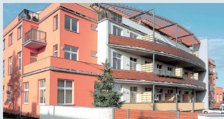
Instalace oken a dveří v architektonicky zajímavém obytném domě v Praze
