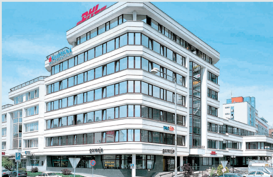
Komerční budova TESCO I v Olomouci – realizace oken, výkladů a vchodových dveří
