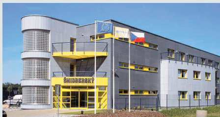
Realizace Oken a dveří administrativní budovy Šmitberský v Pardubicích-Semtině
