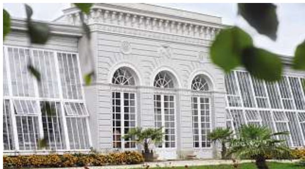
▲ Telč, zámekský skleník Odvlhčovací omítkový systém SUPERSAN
