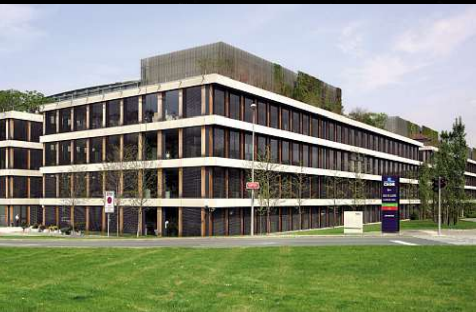
Budova ČSOB, Praha, Stavba roku 2007
