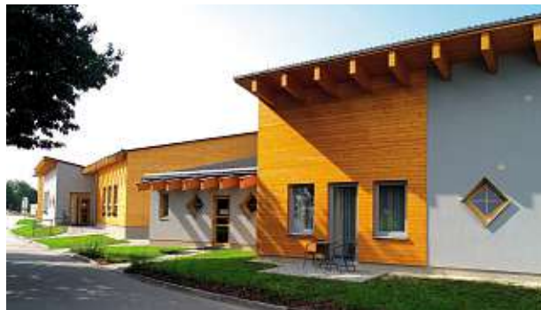
▲ Třeboň, Bertiny lázně Zateplovací systém Cemix THERM P a Silikátová zatíraná omítka
