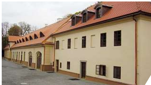
▲ Zámek Štiřín Sanační odvlhčovací omítkový systém SUPERSAN
