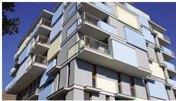
▲ Beroun, bytové domy; ETICS Cemix THERM P a M, Akrylátová zatíraná omítka, Jádrová omítka strojní, Vnitřní štuk
