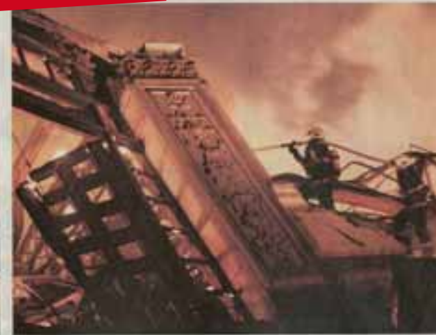
MARNÝ BOJ. Ani rychlý zásah hasičů nezabránil zákeři. Obvodové zdi levého křídla se zřítily. FOTO: MAFA – BŘI KOTÁTEK
