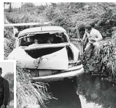
Při crashtestech používal Mercedes parní raketu, která vůz dotlačila až k bariéře. Raketa se občas vymkla kontrole a skončila i s autem ve vodním příkopě, který obklopoval zkušební areál.
