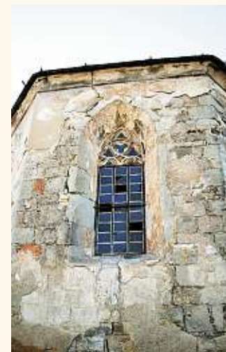
Kostel sv. Jakuba Většího v Želenici má novou střechu, ale fasáda je zcela zničená a některá okna rozbitá. Zvonice má zachovalou šindelovou střechu, zděná část fasády je zničená a dřevěná potřebuje natřít.
