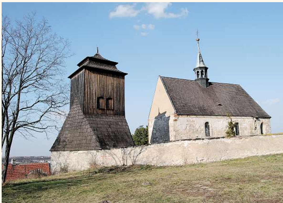
Kostel sv. Jakuba Většího v Želenici má novou střechu, ale fasáda je zcela zničená a některá okna rozbitá. Zvonice má zachovalou šindelovou střechu, zděná část fasády je zničená a dřevěná potřebuje natřít.
