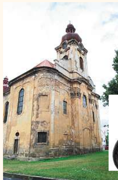
Na celkovou opravu kostela sv. Anny, který je v rekonstrukci, je třeba asi 30 až 40 milionů korun. Pravá strana lodi a nejpřednější část levé strany mají novou střechu. Věžičce chybí zakončení a omítka je silně poškozena.
