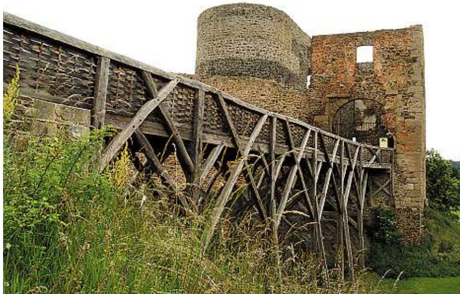
Dřevěný most, který spojuje hrad Krakovec s obcí, byl postaven historickými tesařskými metodami bez železa či hřebů.
