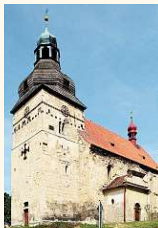
Kvádríkové zdivo kostela Stěti sv. Jana Křtitele je tvořeno kvalitní hradeckou opukou, která byla použita i pro pozdně gotickou loď chrámu sv. Mikuláše v Lounech.
