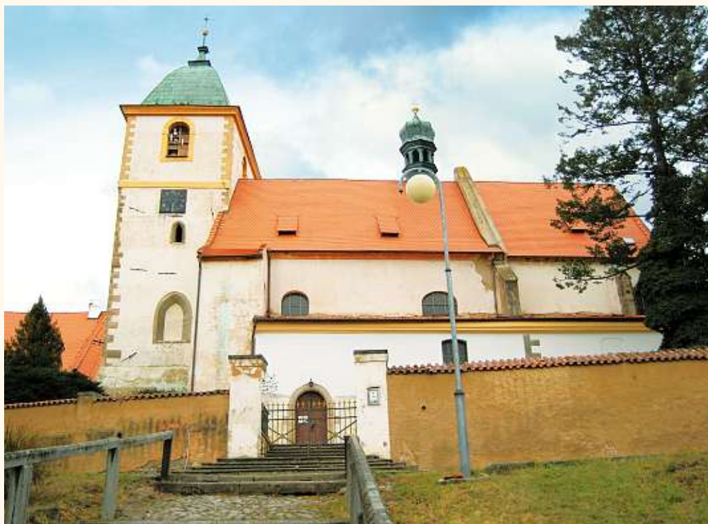
Kostel Narození Panny Marie ve Starém Plzenci prochází celkovou rekonstrukcí. Loď kostela má novou střechu, je opraven krov i střešní plášť. Věž kostela i fasáda dosud čekají na opravu, hodiny na jdoucí ručičky.
