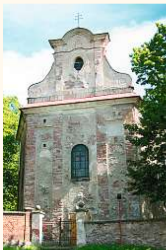
Do kostela v Ruprechticích zatéká, omítky jsou dezolátní. Rovněž obecní mobiliář podél hřbitovní zdi kostelu škodí.
