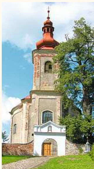
Dynamický sloh kostela sv. Anny ve Vižňově narušují provizorně krytá střecha, chybějící kamenné římsy a opadaná omítka.
