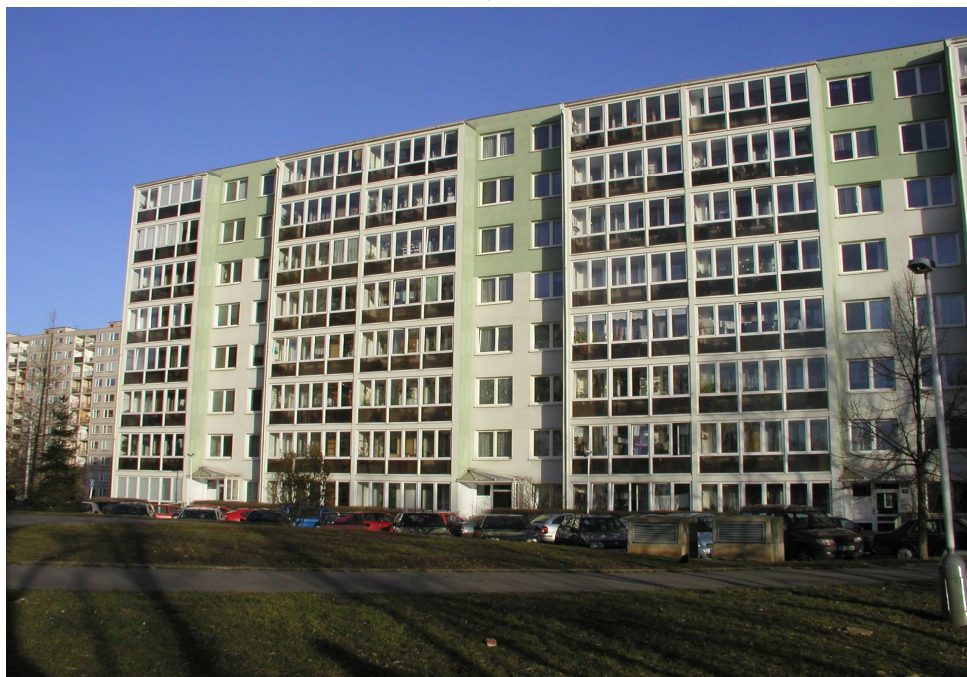
Panelové domy stárnou a jejich vlastníci by uvítali lepší možnosti čerpání úvěrů na opravy. Foto: Ivan Ryšavý
