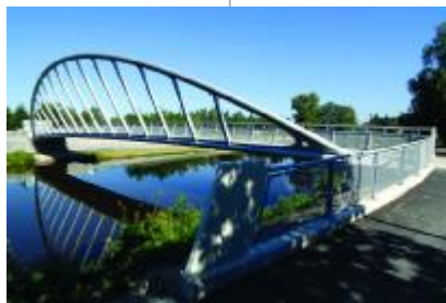
Mezi Stavby r. 2007 patří i lávka pro cyklisty přes Vltavu v Č. Budějovicích. Foto: archiv
