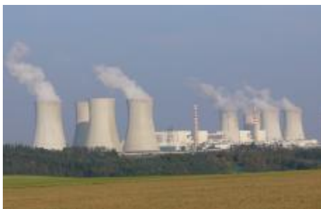
Jaderná elektrárna Dukovany je významným zdrojem české energetické soustavy. Foto: Wikipedia
