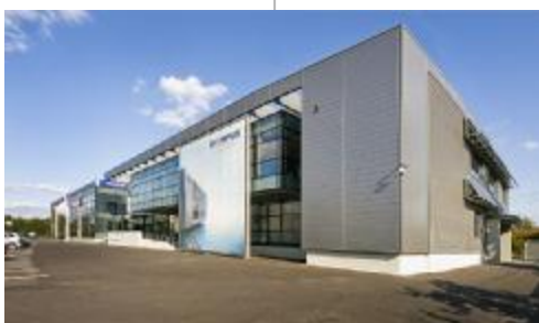
Nové moderní technologické centrum Olympus Medical Products Czech v Přerově.
