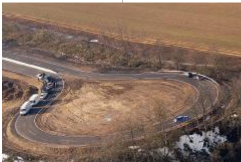
Výstavba dopravní sítě v ČR se po nástupu nového zákona zbaví řady bloků. Foto: České fórum
