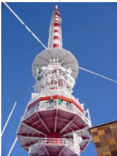
Vysílač na Kleti je jedním z těch, jichž se týká letošní modernizace. Foto: ČRa
