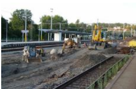
Modernizované železniční koridory umožní cestovat po kolejích rychleji.
