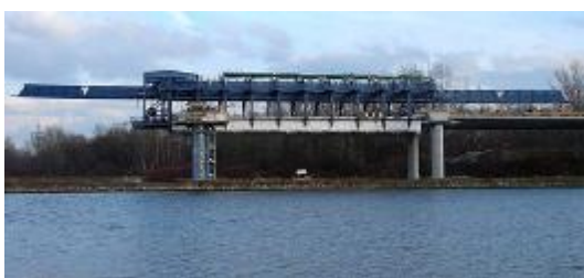
Technologie výstavby mostu přes Odru je v ČR konstrukčním unikátem.
