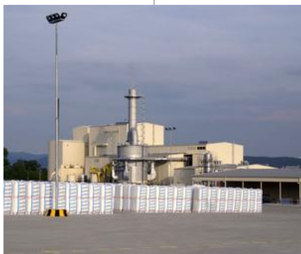
Nová továrna Knauf Insulation v Krupce.
