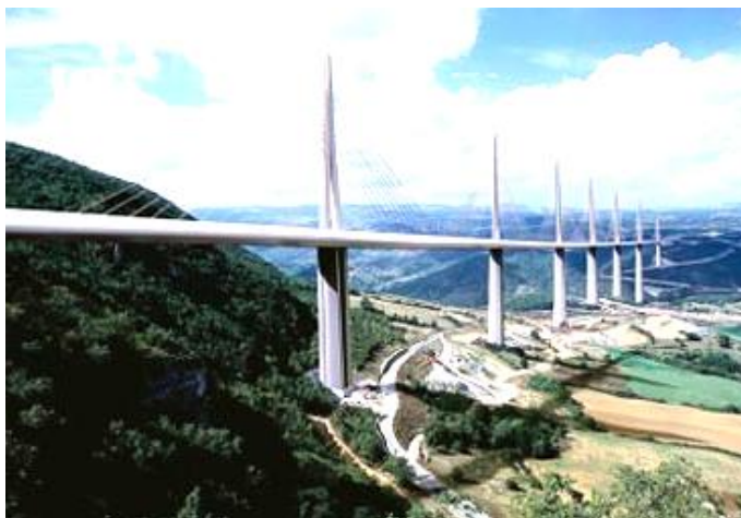
Primát nejvyšší mostní konstrukce na světě patří nyní Francii.
