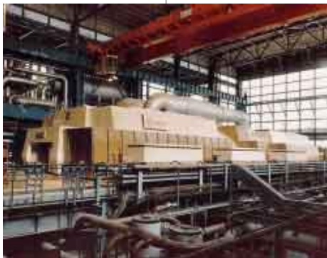
Dvojice nových 500 MW bloků s turbosoustrojím v Šen-Tchou dodává energii pro Peking.
