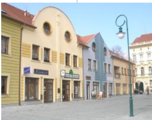
Holandská ulice vznikla v centru Berouna i díky partnerství s Rijswijkem, předměstím Haagu, na místě zničeném demolicemi z doby »socialistické výstavby«.
