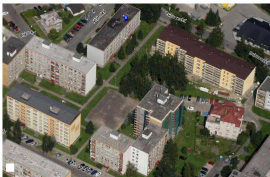
Betonový plácek na sídlíšti v Jablunkově se zanedlouho změní v moderní víceúčelové hřiště. Foto: archiv
