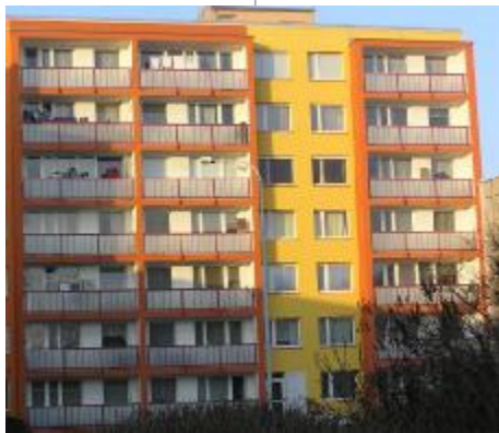
Kdyby měly být opraveny či rekonstruovány všechny panelové domy v ČR, vyžádalo by si to zhruba 350 mld. Kč. Ilustrační foto: Irena Hošková
