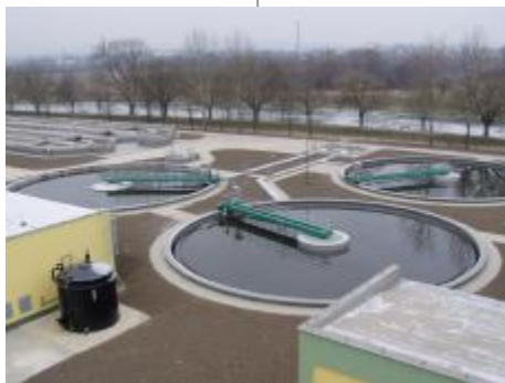
ČOV v Uherském Hradišti.
