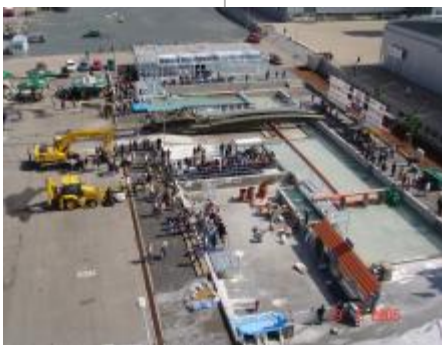
Z loňských ukázek protipovodňových opatření. Foto: archiv
