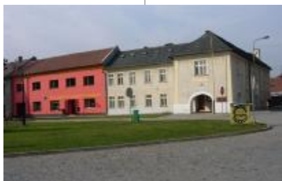
Městský úřad v Némčicích n. H. (nárožní budova vpravo). Foto: archiv
