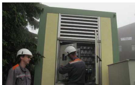
Montáž nových rozvaděčů.
