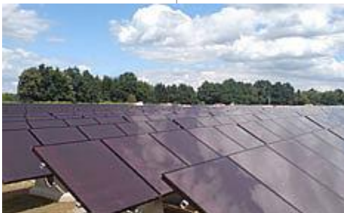
Fotovoltaická elektrárna Dívčice v jižních Čechách je zatím nejvýkonnější projekt společnosti Energy 21.
