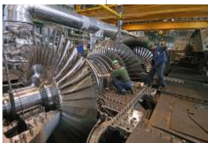
Modernizace JE Dukovany.
