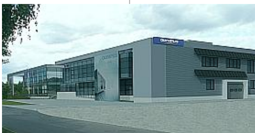
V Přerově vyroste nové unikátní technologické centrum firmy Olympus Medical.
