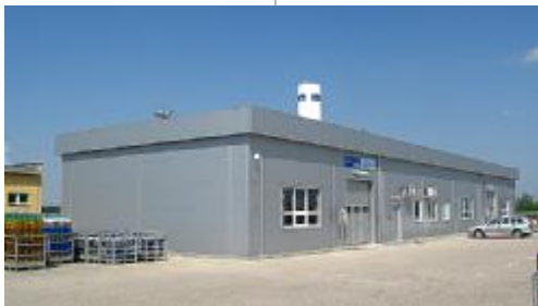
Novou plnárnu medicijních plynů otevřela firma Linde Gas v Praze.
