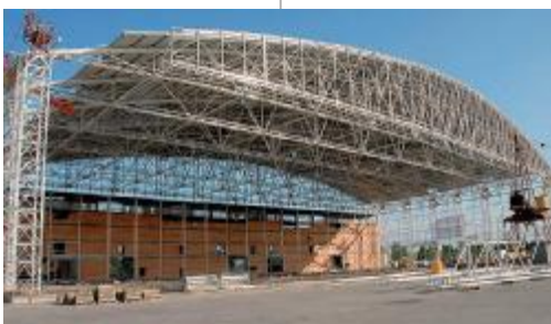
Při výstavbě hangáru se uplatnila unikátní konstrukce z vítkovických železáren.
