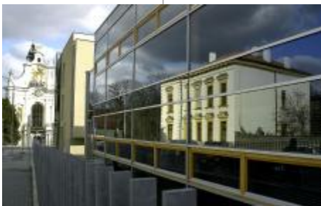
Nový kampus VUT v Brně je unikátním objektem nejen po technické, ale i architektonické stránce.
