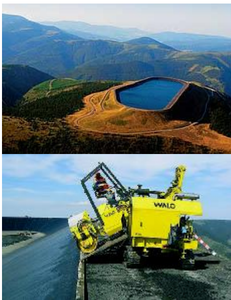
Povrch přečerpávací nádrže (nahore) pokryla nepropustnou vrstvou švédská firma Walo.
