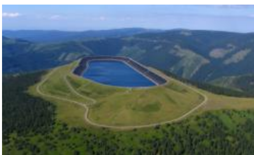
Elektrárna Dlouhé Stráně v Hrubém Jeseníku využívá výškový rozdíl mezi přehradou na Divoké Desné a nádrží na vrcholu Mravenečnicku (1350 m n. m.).
