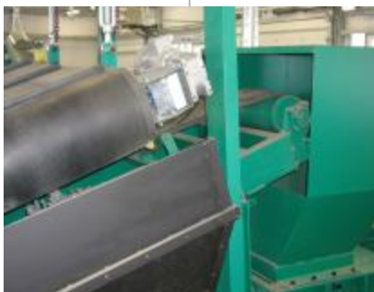
Částečně přetříděný elektroodpad je dopravován k další technologické operaci.
