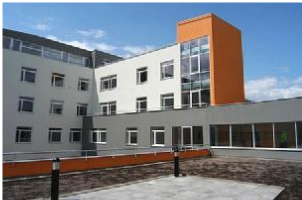
Brněnské Vysoké učení technické se snaží soustředit své fakulty do jednoho místa – elektrotechnici budou po prázdninách v novém.
