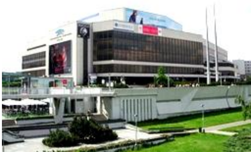
Metoda CM@Risk byla uplatněna například při rekonstrukci Kongresového centra Praha. Foto: archiv
