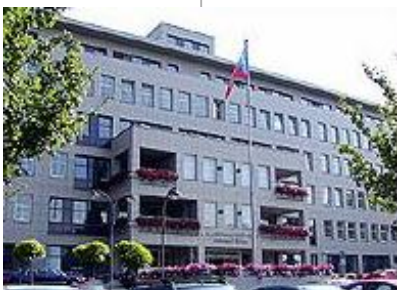
Budova Krajského úřadu Moravskoslezského kraje Foto: archiv
