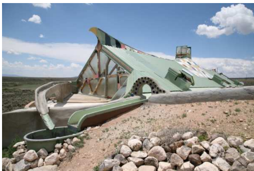
Ukázka jedné realizované „zeměloď“ Phoenix Earthship (Nové Mexiko) se systémem zadržování dešťové vody. Foto: archiv
