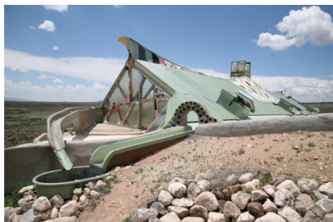
Kukázka jedné realizované »zeměloďi« Phoenix Earthship (Nové Mexiko) se systémem zadržování dešťové vody. Foto: archiv
