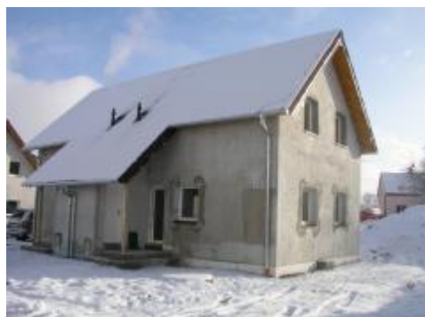
Zkolaudované dvojdomky čeká ještě povrchová úprava. Foto: Simona Dvořáčková
