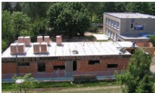
Snímek z průběhu výstavby nového pavilonu školky. Foto: MěÚ Hlučín
