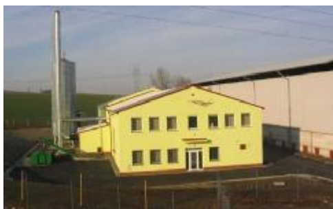
Biokotelna v obci Roštín.
