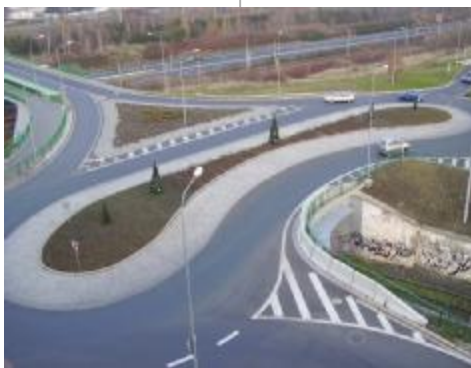
Pětiramenná malá okružní křižovatka v Chomutovské ulici v Mostě loni získala Cenu společnosti 3M Česko. Foto archiv
