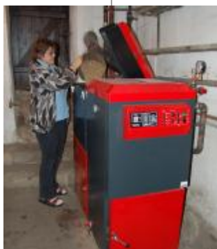
Instalaci kotlů na různé typy biomasy (kusové dřevo, bílé či hnědé pelety, štěpka, obilí) si před dvěma roky úspěšně vyzkoušeli v Mikroregionu Telčsko.
