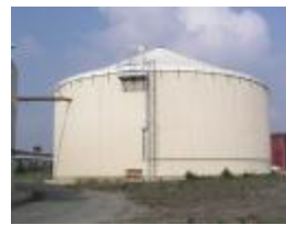
Bioplynová stanice v Kněžicích. Foto: archiv
