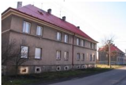
Jako první se budou rekonstruovat dva domy s celkem 16 byty IV. kategorie v ulici Petra Cingra, kde většinu nájemníků čeká soudní vystěhování. Bydlení v opravených bytech budou moci zájemci získat prostřednictvím licitace. Foto: archiv města
