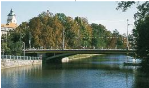
Také na rekonstrukci Krumlovského mostu v Českých Budějovicích, poničeného po povodni v roce 2002, byl vypsan veřejný tendr. Foto: archiv
